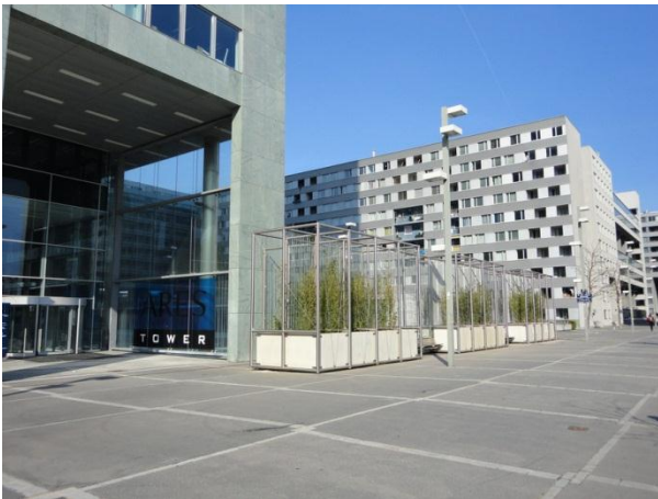
Windschutzmaßnahme in der Donaucity in Wien.
