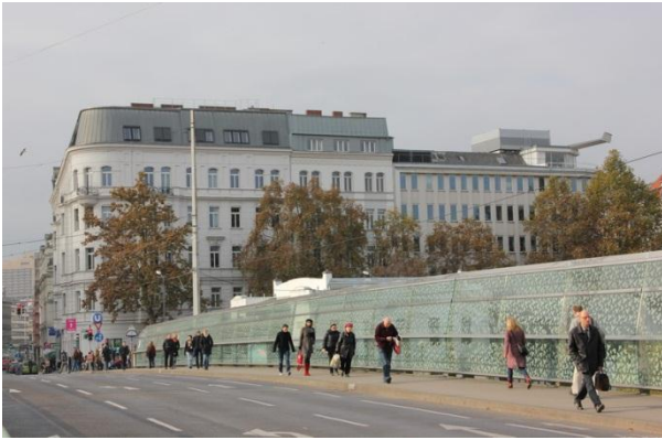
Windschutzmaßnahme auf der Friedensbrücke in Wien nach Erstellung einer Windkomfortstudie durch Weatherpark.
